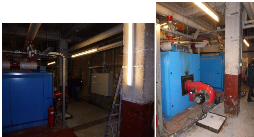
Figures 5 : chaufferie avec chaudières fixes de grosses capacités et colonnes de fondations
